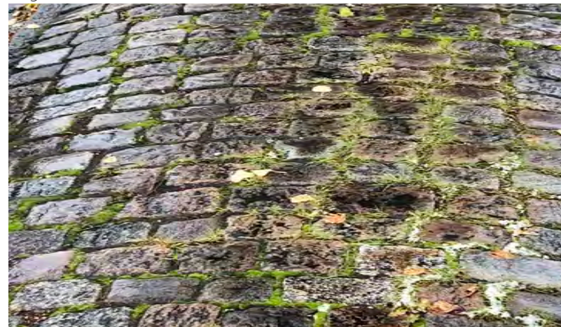
Beläggning av storgatsten, hållbart material med hög dignitet
